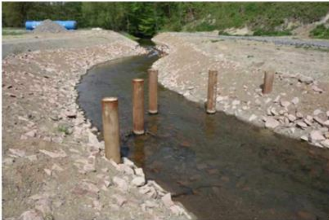
Abbildung 8: V-Rechen im Bereich des HRB Wippra (Eiden 2016).
