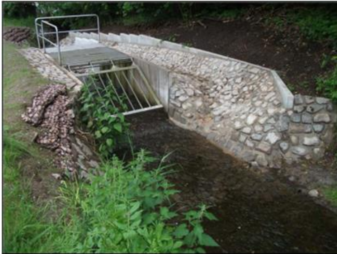
Abbildung 7: Treibgut-/Geschiebefang mit seitlicher Überlaufstrecke (Landeshauptstadt Dresden Umweltamt, 2016).
