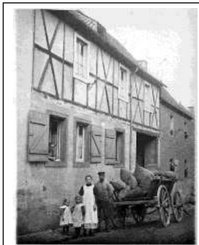
Erdgeschoß gemauert, Fenster mit Natursteingewände und Klappläden, Obergeschoß Fachwerk mit Holzbeleidungen um die Fenster
